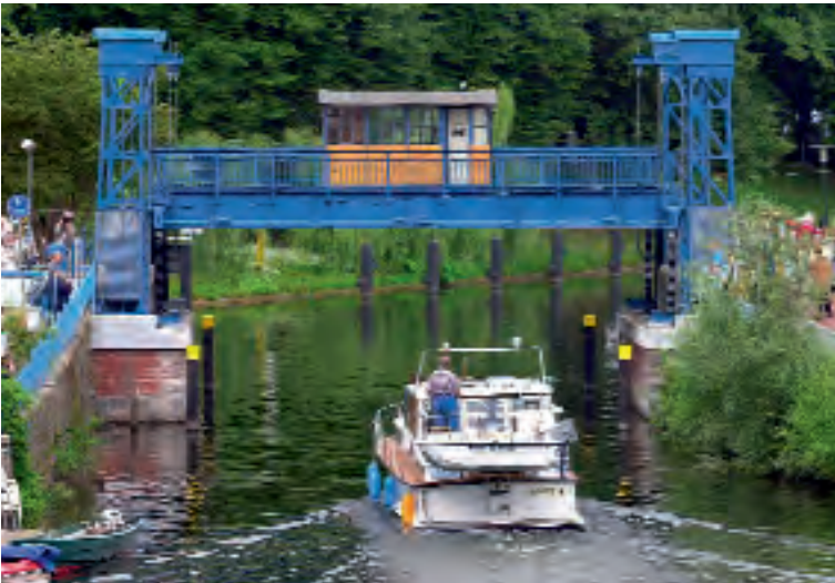
Fluss Elde, Hubbrücke in Plau am See
